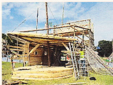
Ein Schiff entsteht...
